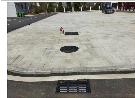
雨水口+雨水井 (2024 年 4 月)
