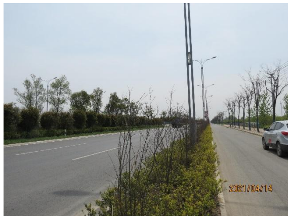
路基工程区绿化
