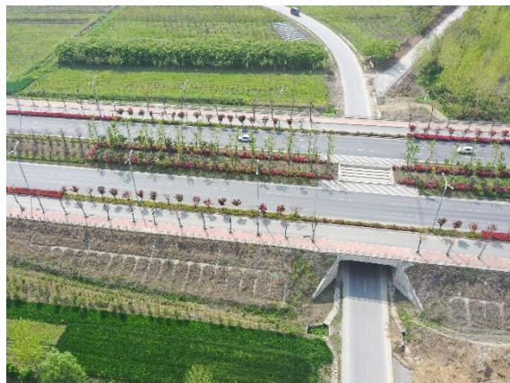
路基工程区框格护坡
