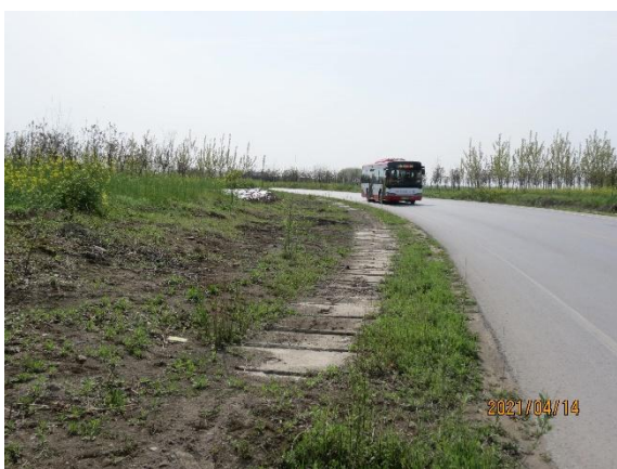
改迁建工程区盖板排水沟
