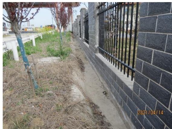
管护设施区混凝土排水沟
