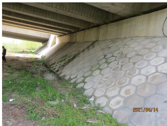
桥梁工程区混凝土护坡
