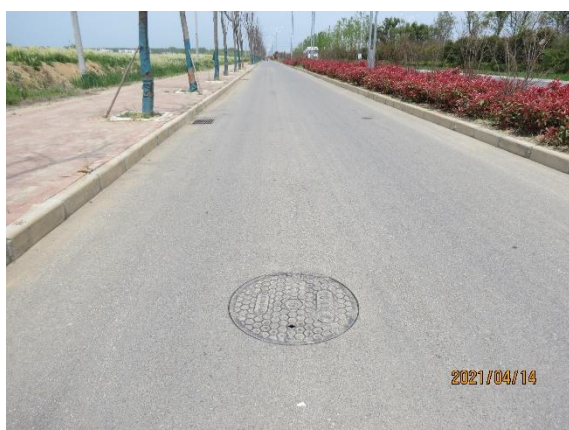
路基工程区雨水井
