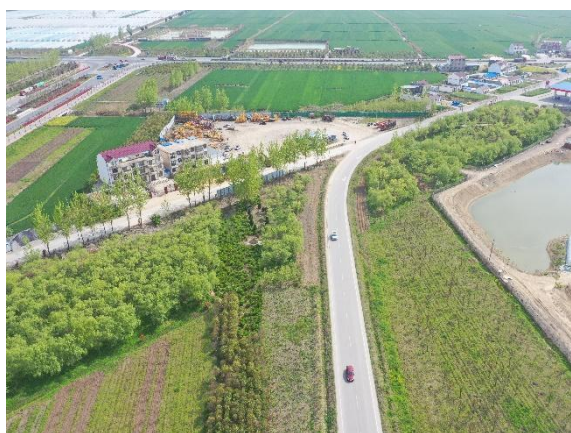
改迁建工程区 329 道路两侧土质排水沟
