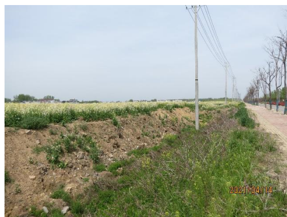
路基工程区土质排水沟
