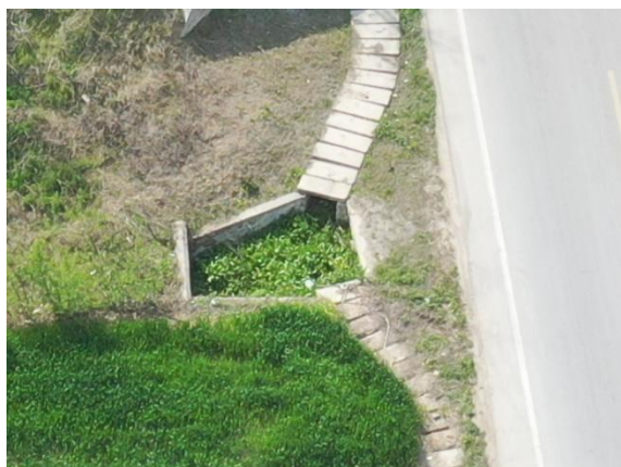
改迁建工程区沉沙池
