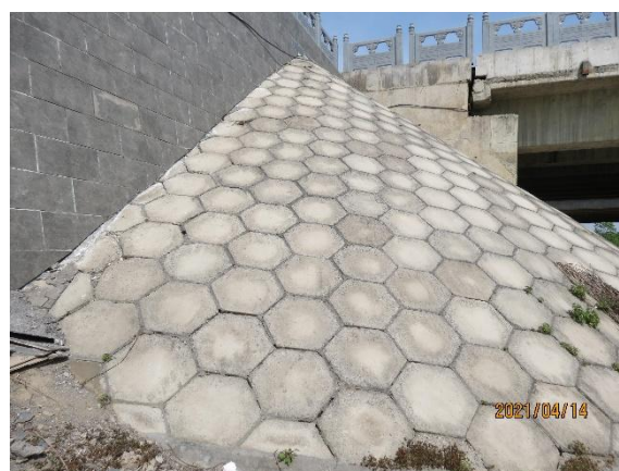
桥梁工程区混凝土护坡
