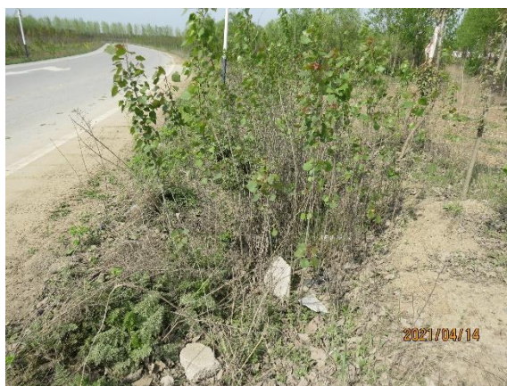
改迁建工程区土质排水沟
