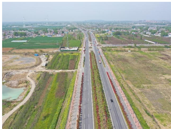
路基工程区绿化
