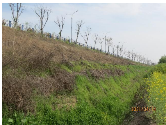
路基工程区边坡绿化
