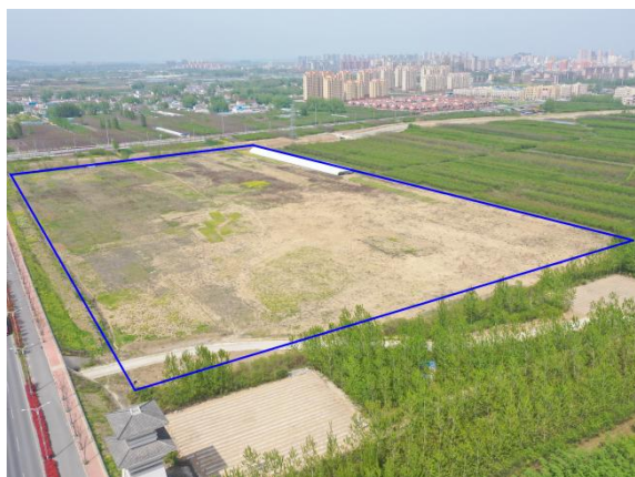
施工场地区撒播草籽
