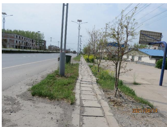
路基工程区盖板排水沟
