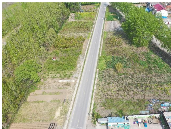
改迁建工程区 329 道路两侧盖板排水沟
