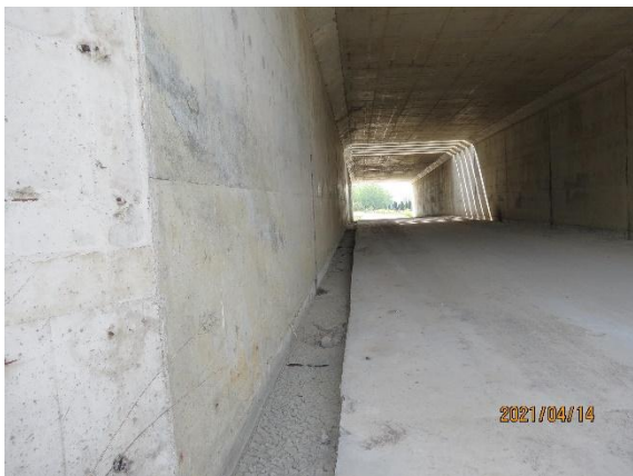
改迁建工程区混凝土排水沟
