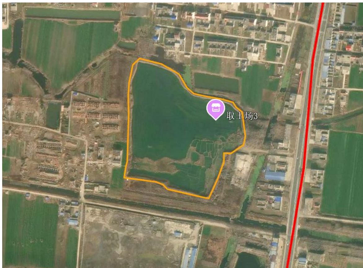
3#取土场施工后影像
