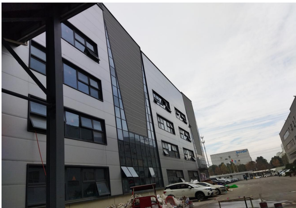
综合楼及联合车间现场照片（2023 年 12 月）
