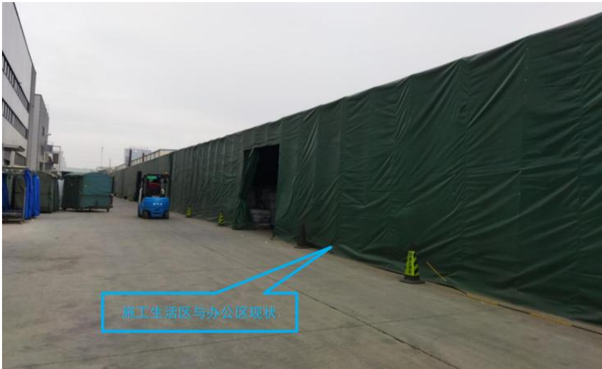
场外扰动区中施工生活区与办公区现状（2023年12月）
