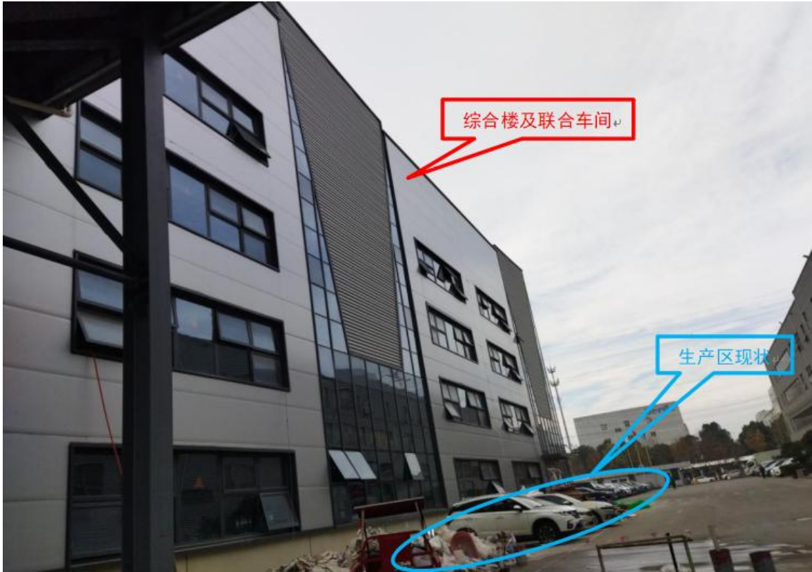
场外扰动区中的生产区现状（2023年12月）
