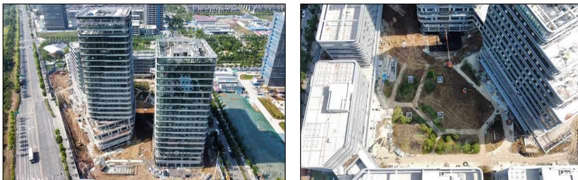
图 1.5-4 蜀山高科数字经济示范园项目施工现状图
