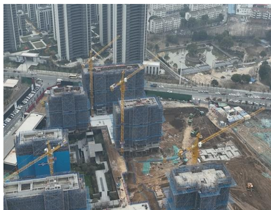
红线外施工场地现状（2024年3月）
