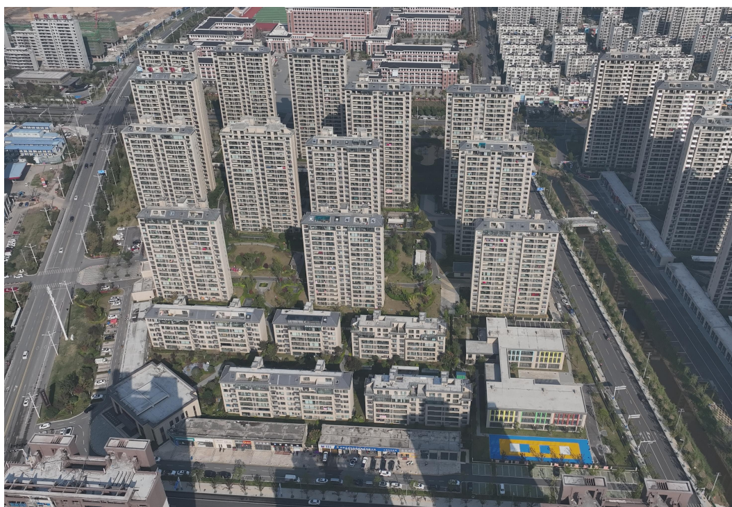
图 1.1 西侧地块建筑物航拍图（2023 年 11 月）
