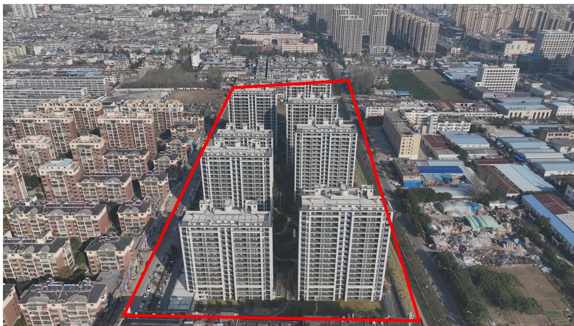
图 1.2 建筑物航拍图（2023 年 11 月）
