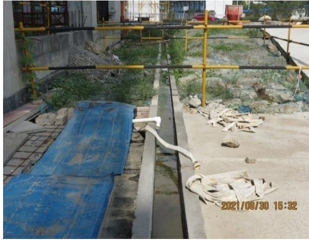
浆砌砖排水沟
