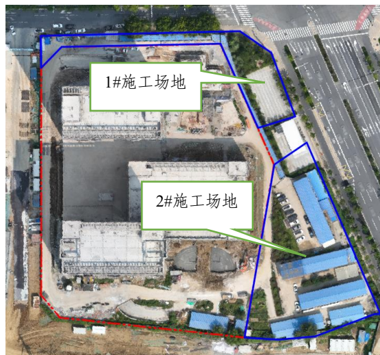
图 1.8 施工场地现状图（2023.9）
