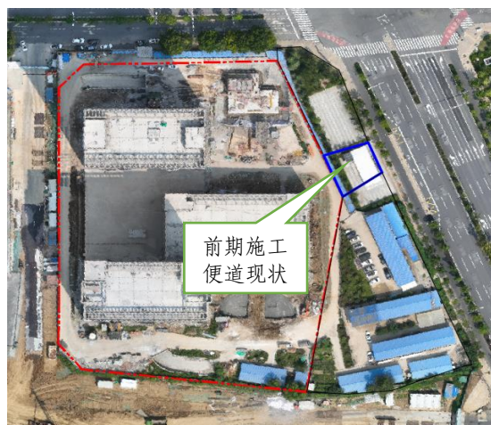
图 1.12 施工道路现状图（2023 年 9 月）
