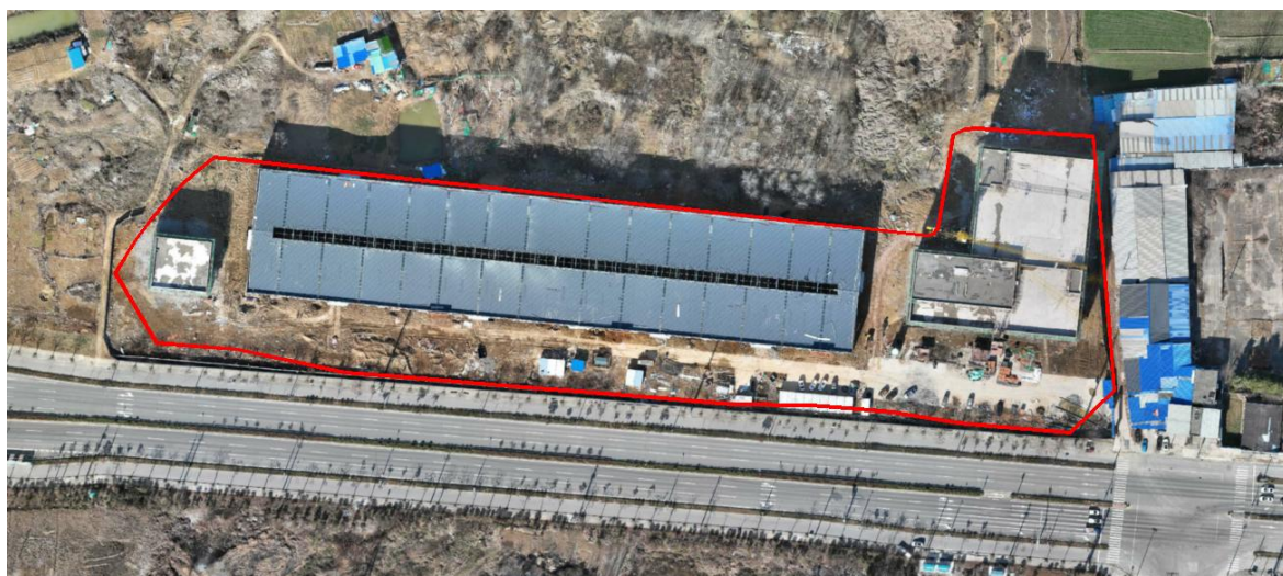
图 1.1 项目建设现状（2024 年 1 月）
