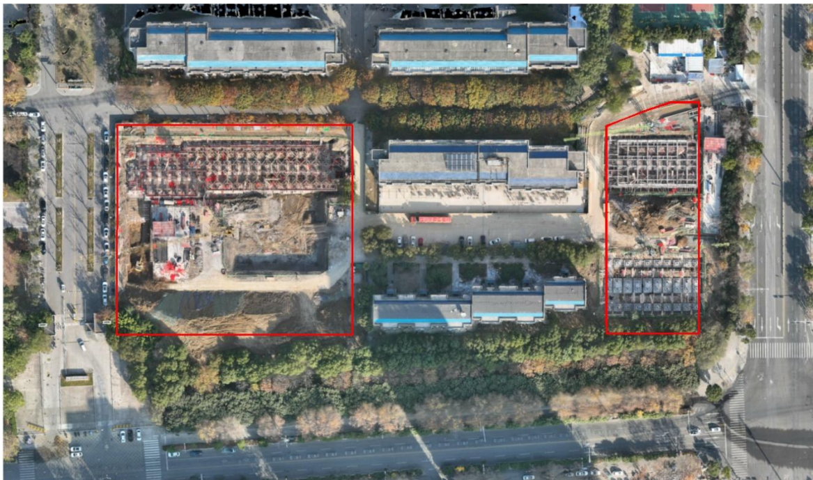
图 1.1 项目建设现状
