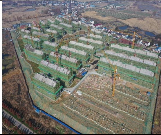
项目建设现状（2021 年 12 月）
