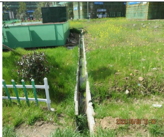
浆砌砖排水沟（2022 年 3 月）
