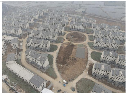
项目建设现状（2022 年 12 月）
