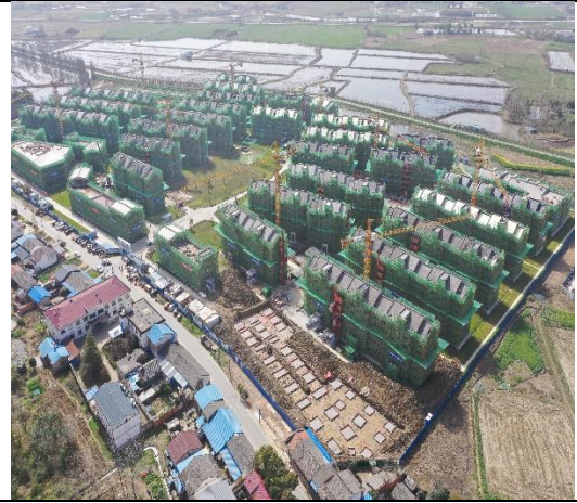
项目建设现状（2022 年 3 月）
