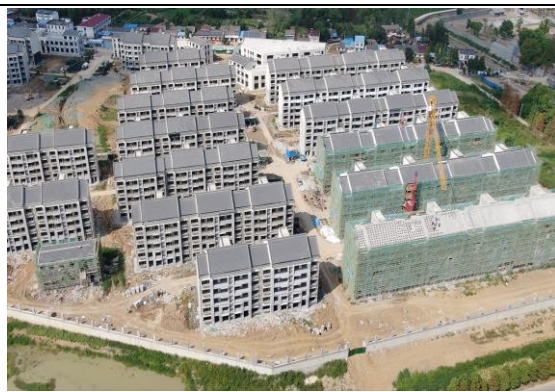
项目建设现状（2022 年 9 月）
