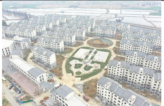
项目建设现状（2023 年 2 月）
