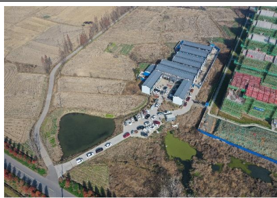
场外临建现状（2021 年 12 月）
