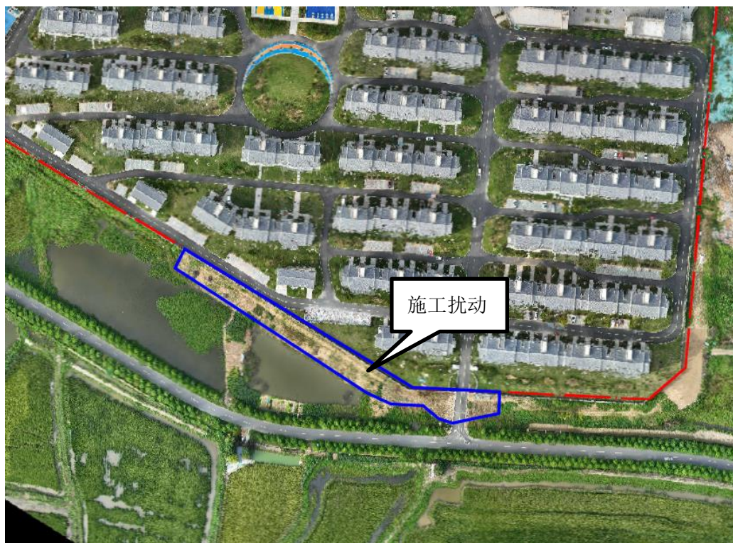
施工扰动现状（2023 年 7 月）
