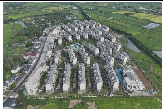
项目建设现状（2023 年 9 月）
