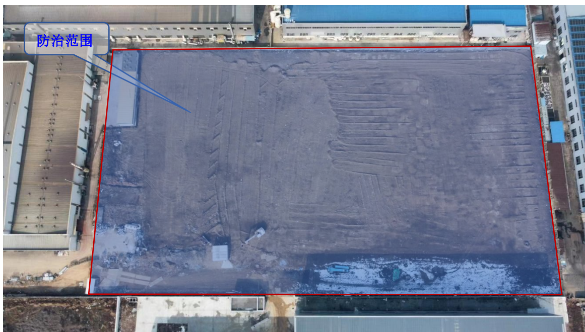
图 1.1-1 项目现场航拍图
