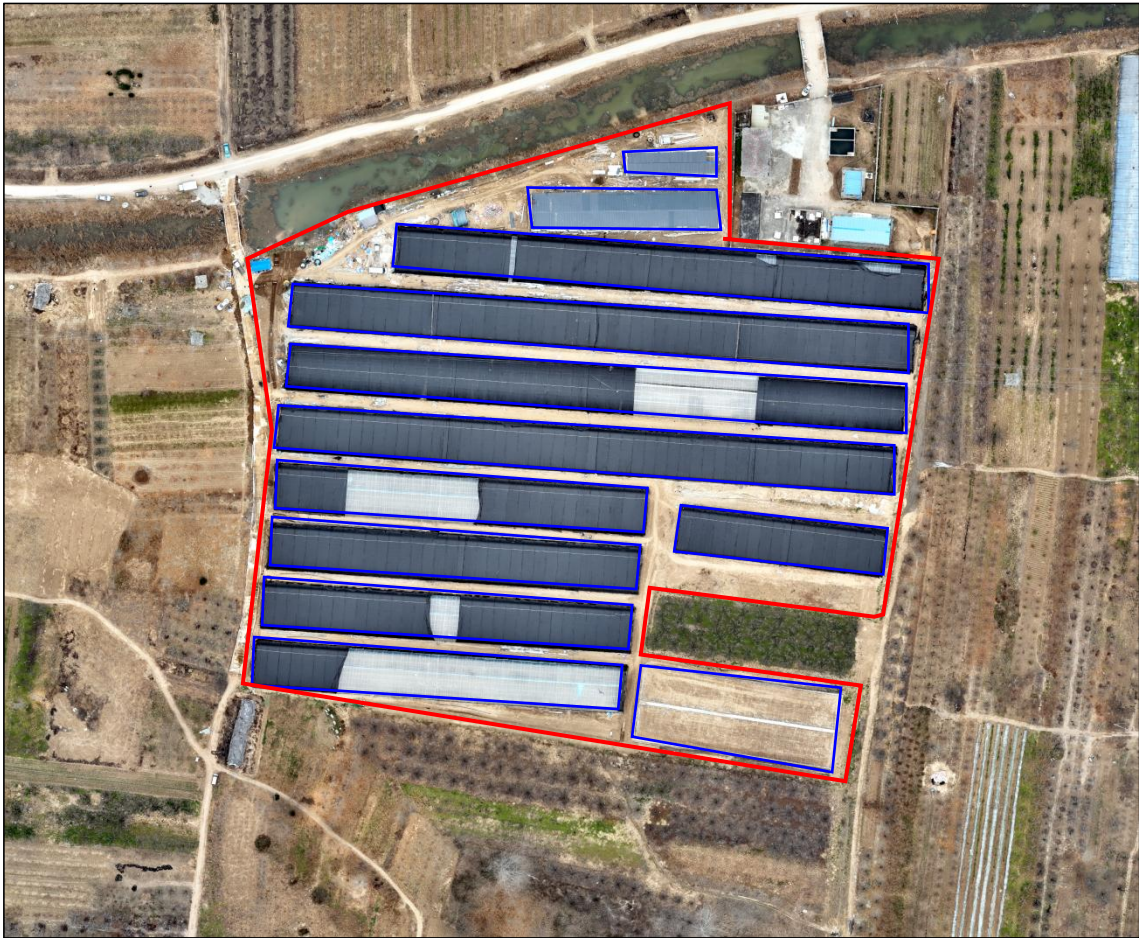
图 1.2-2 建构筑物施工现状图
