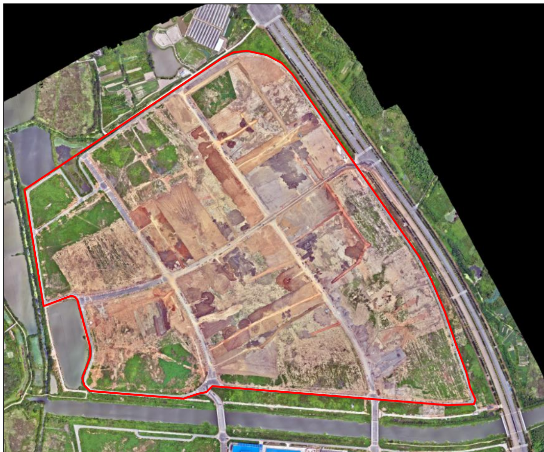
图 2.6-2 项目施工现状图
