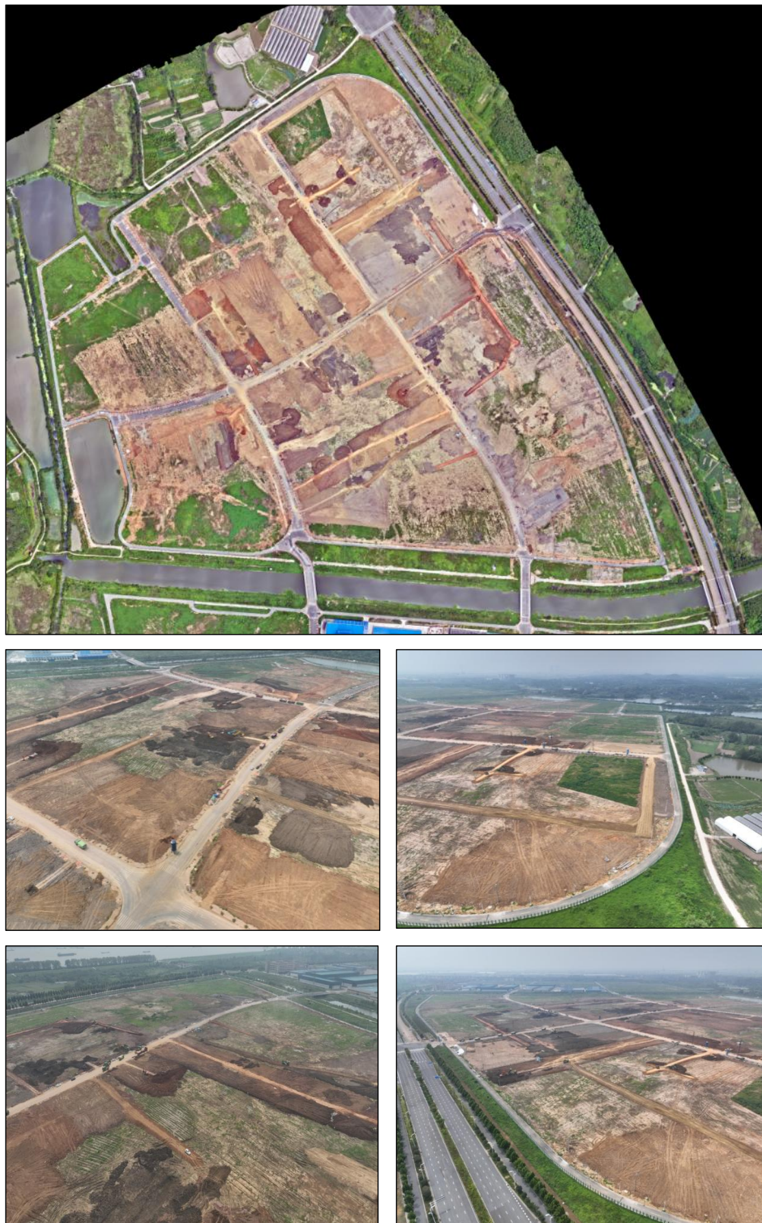
图 1.1-1 项目施工现状图（2023 年 8 月）
