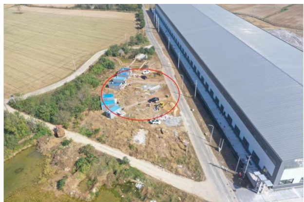
图 1.3 施工场地现状图
