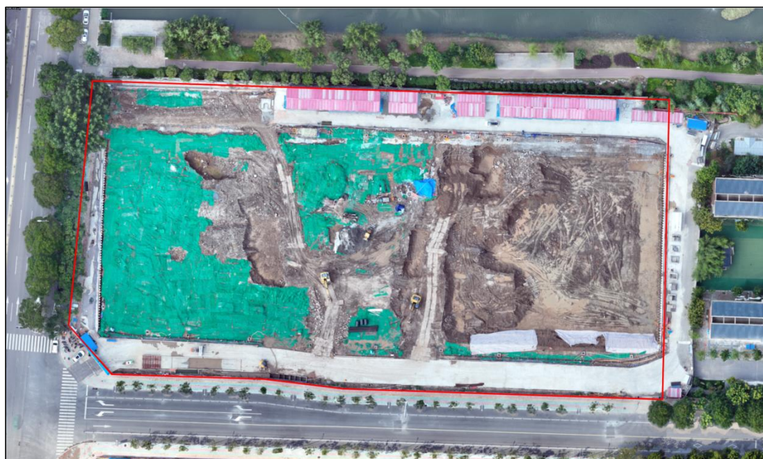
图 2.6-1 项目施工现状图（2023 年 9 月）
