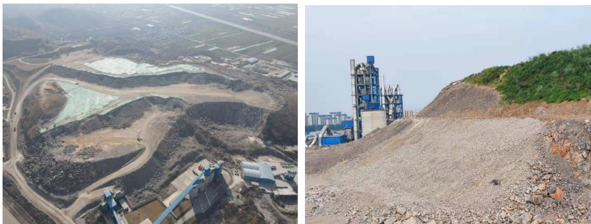
图 2.1 弃方项目现状
