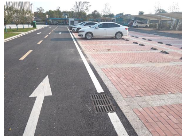
项目区内雨水口现状
