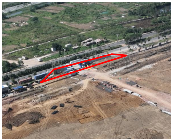
图 2.7 1#施工便道现状（2023 年 9 月）
