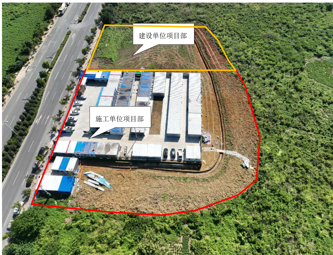
图 2.5 施工场地现状图（2023 年 9 月）
