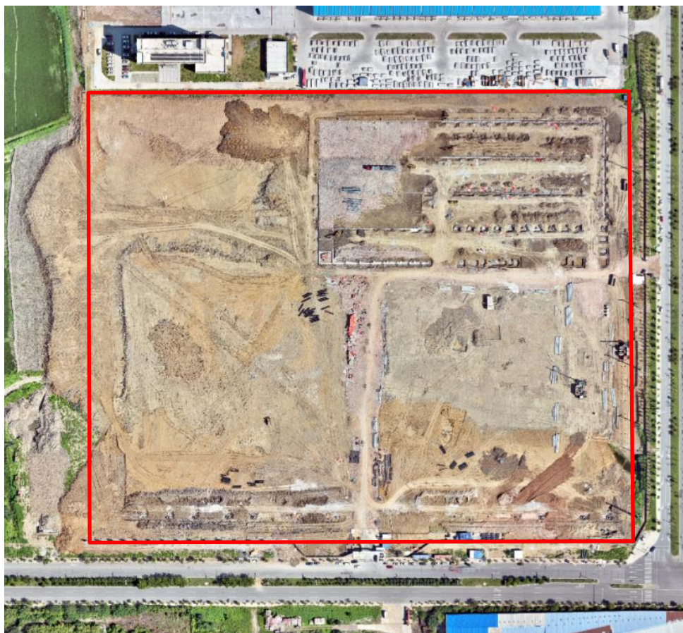
图 1.1 项目建设现状图（2023 年 9 月）
