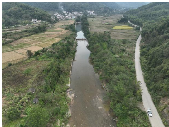
河道清淤疏浚工程
