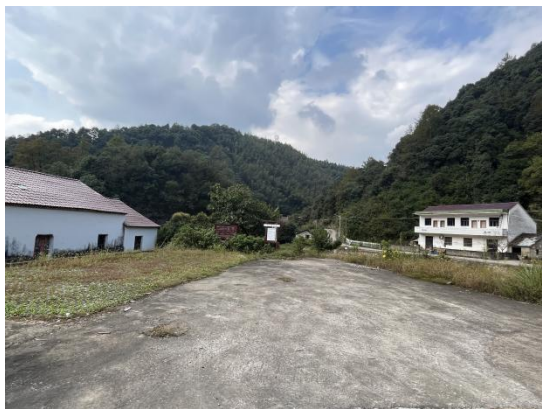
施工场地已恢复
