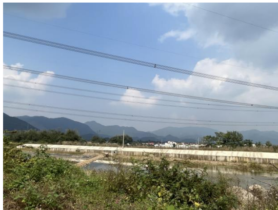
河堤修复工程 K12+236.2~K12+436.2 段
