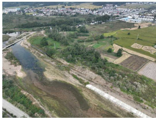
施工便道已恢复
