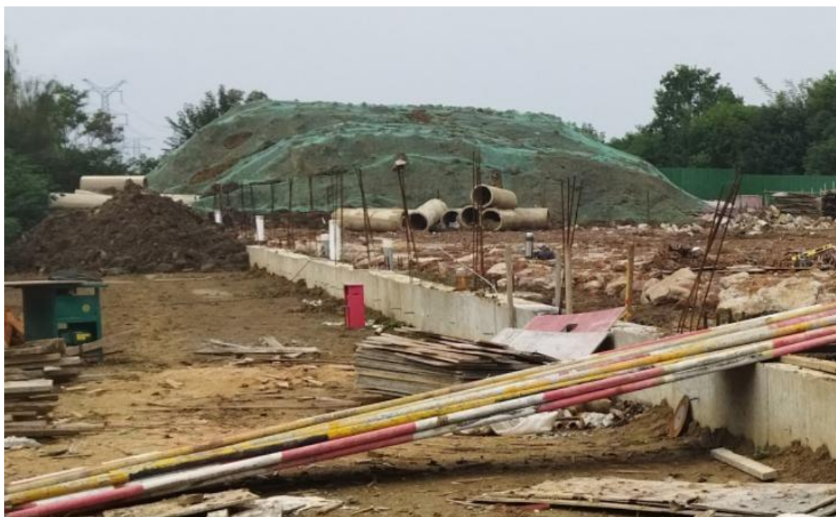
图 1.7 临时堆土场现场照片（2023 年 10 月）
