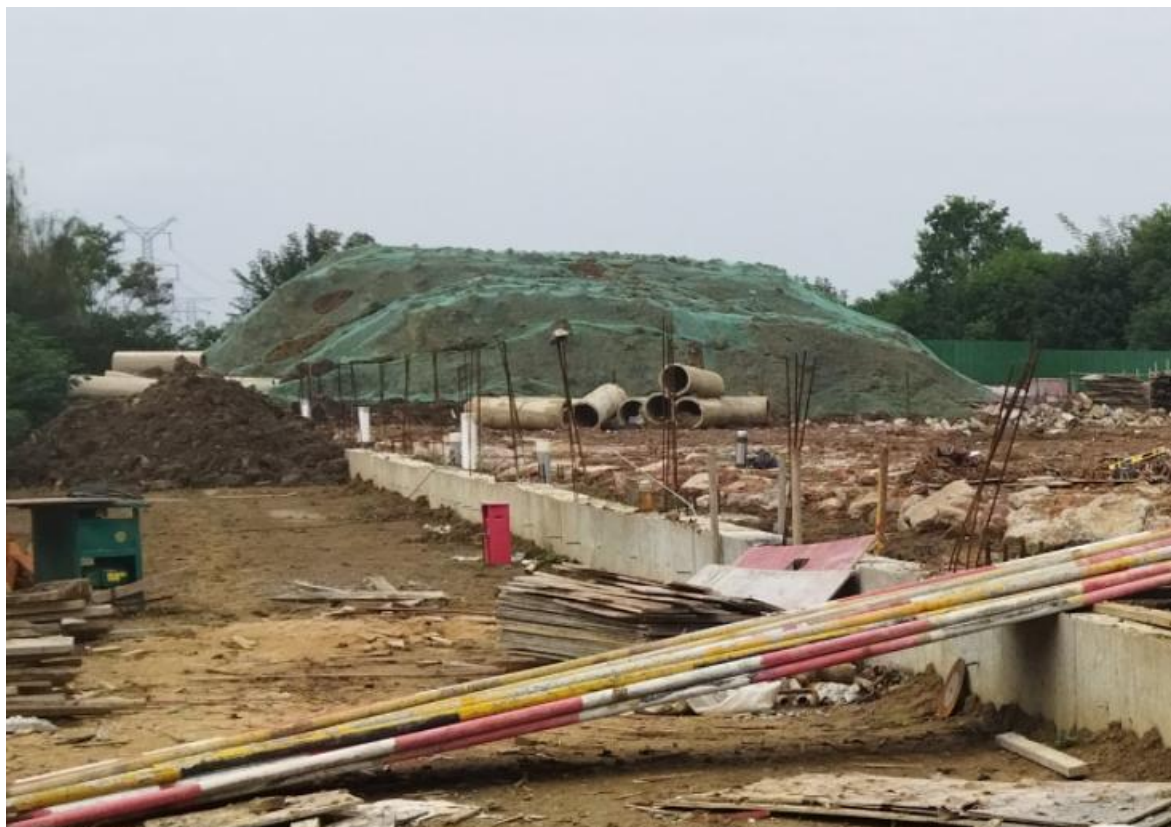
图 5.2 临时堆土场临时苫盖措施（2023 年 10 月）
