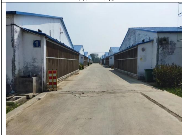
项目区内部道路
