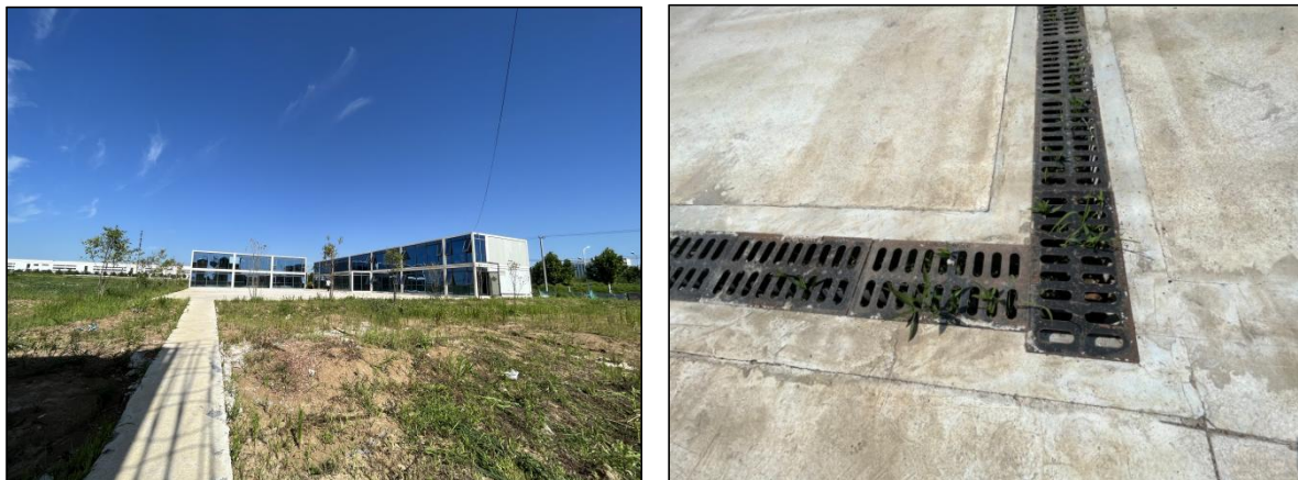
图 3.3-1 临时绿化和盖板排水沟
