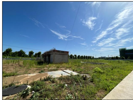
消防泵房和消防水罐
