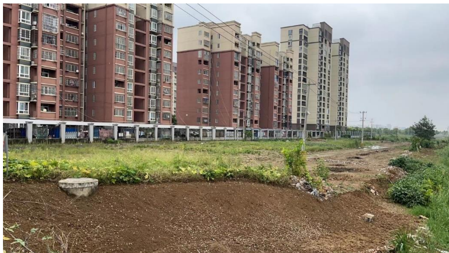
图 1.2 施工生产生活区现状
