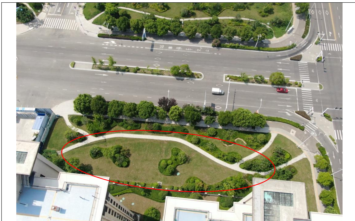
1#施工生产生活区现状
