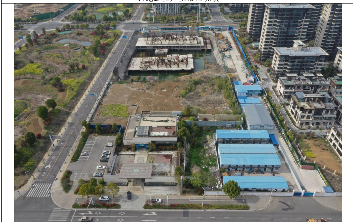
2#、3#施工生产生活区现状
