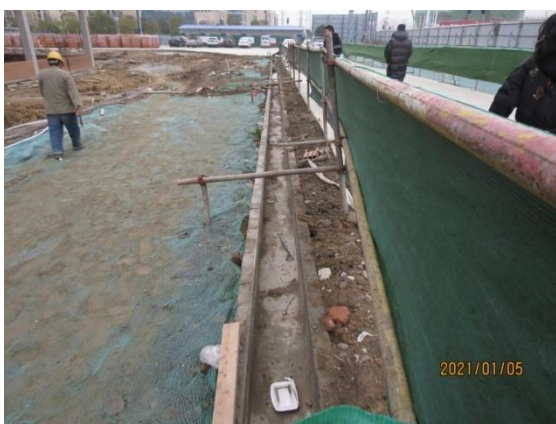
施工期临时排水沟
