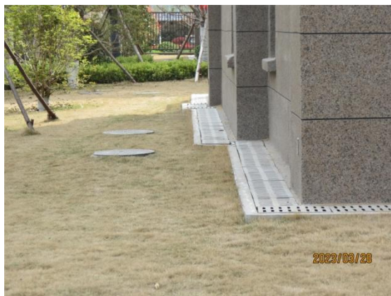
沿建筑物四周布设盖板排水沟
