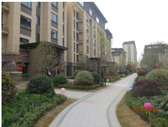
建构筑物工程区 A 区绿化
