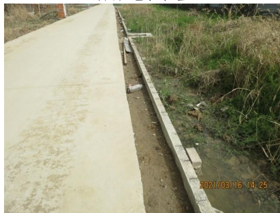
沿内部施工便道布设排水沟
