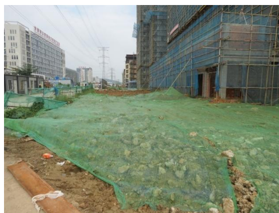
裸露地表苫盖
