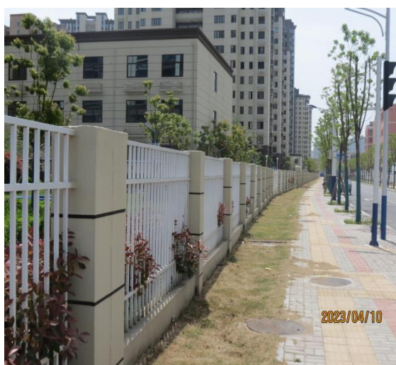
代建市政道路现状
