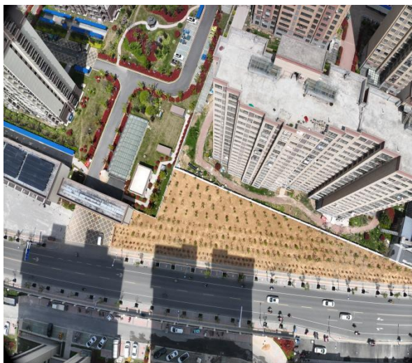
2#施工场地现状
