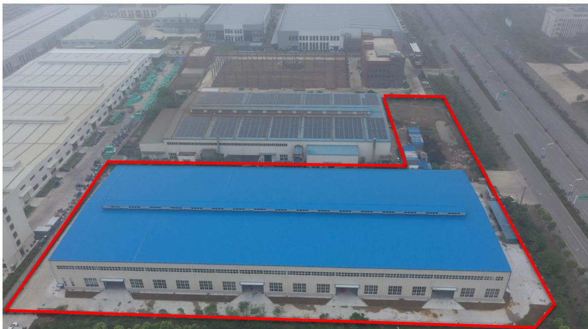
图 1.1 项目现状航拍
