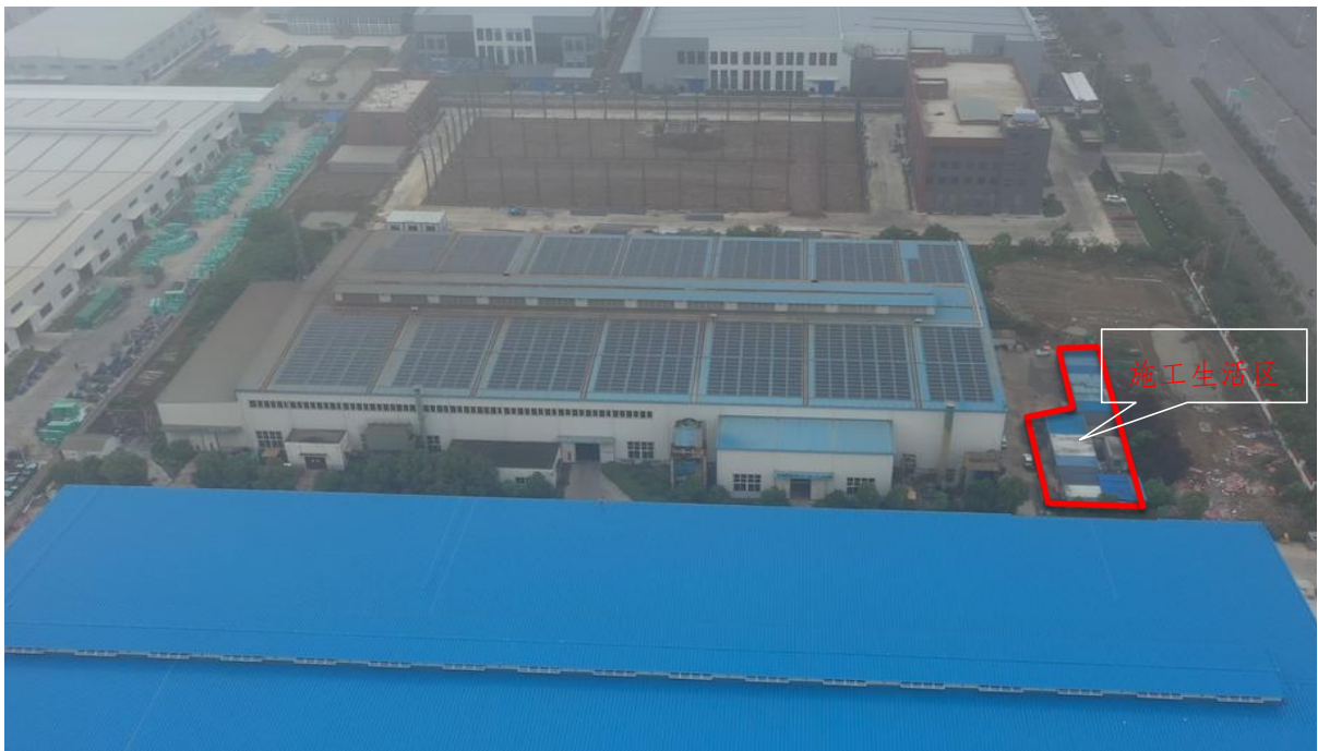
图 1.4 施工生产区现状
