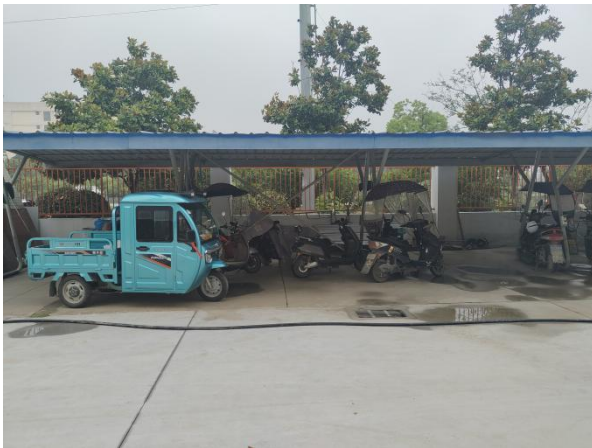
厂区已建成非机动车停车场
