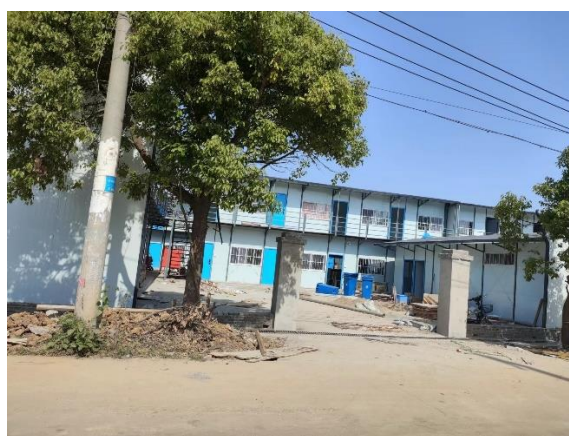
施工场地现状
