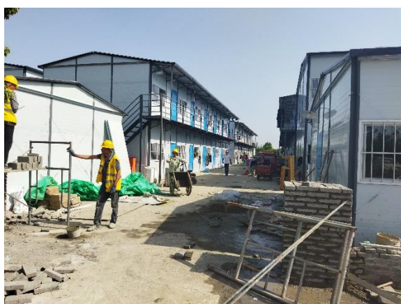
施工场地现状
