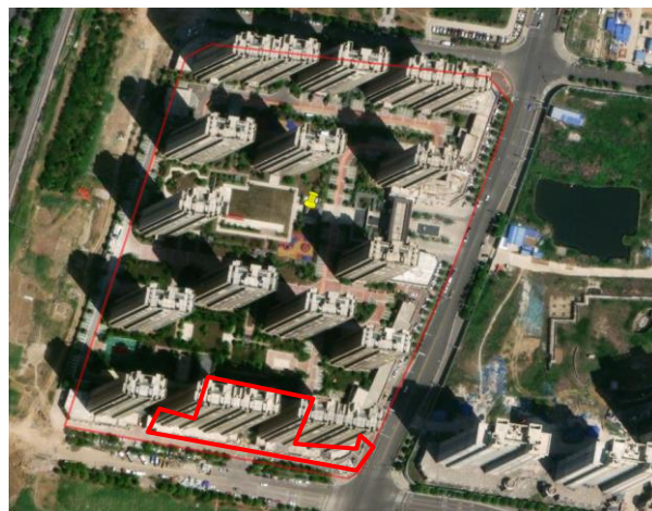
一期施工场地现状
