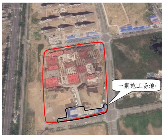
一期施工场地
