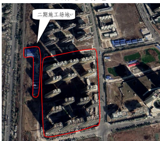
二期施工场地
