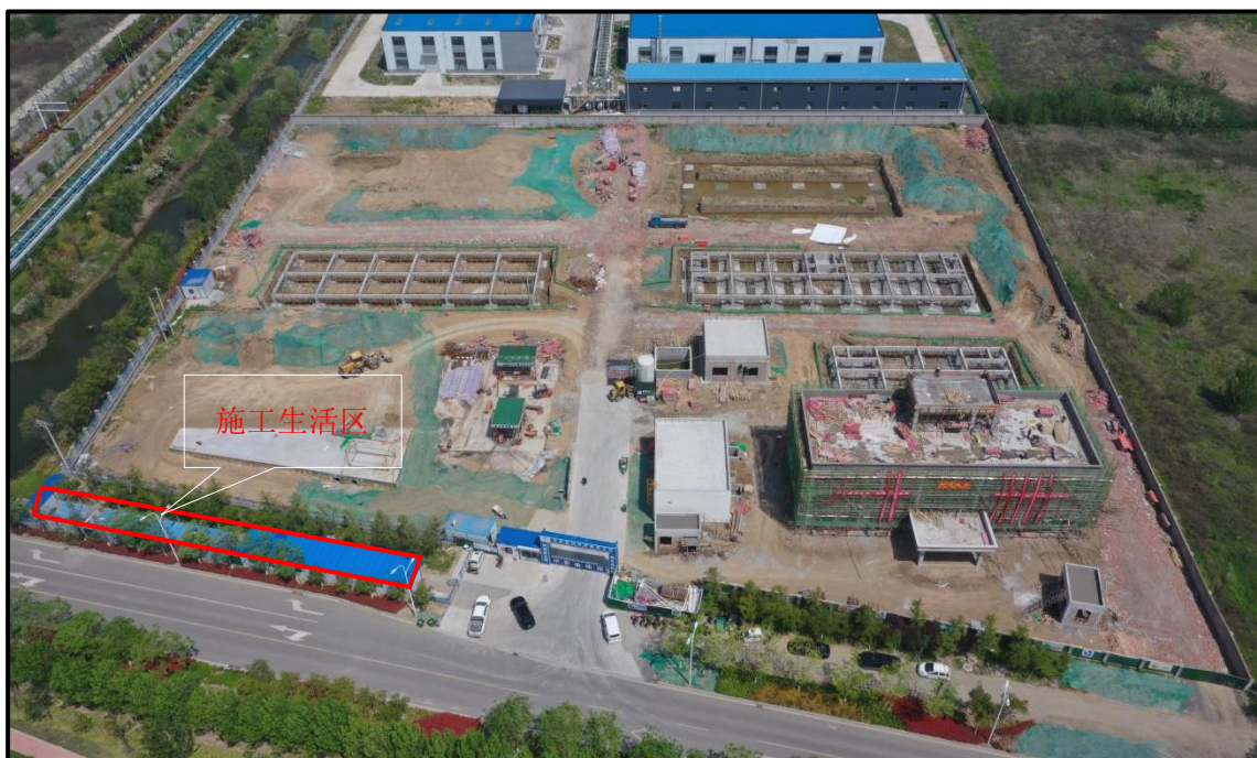
图 1.6 施工生产区现状
