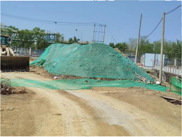
临时堆土密目网苫盖
