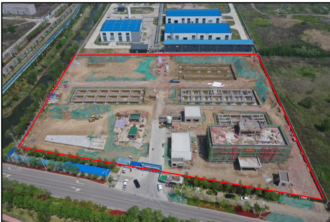
图 1.2 项目现状航拍
