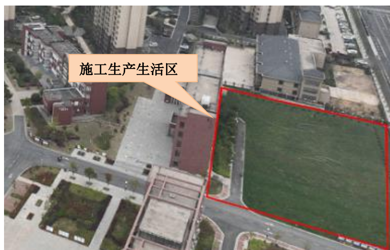
图 1.2 施工生产生活区现场照片（2023 年 3 月）
