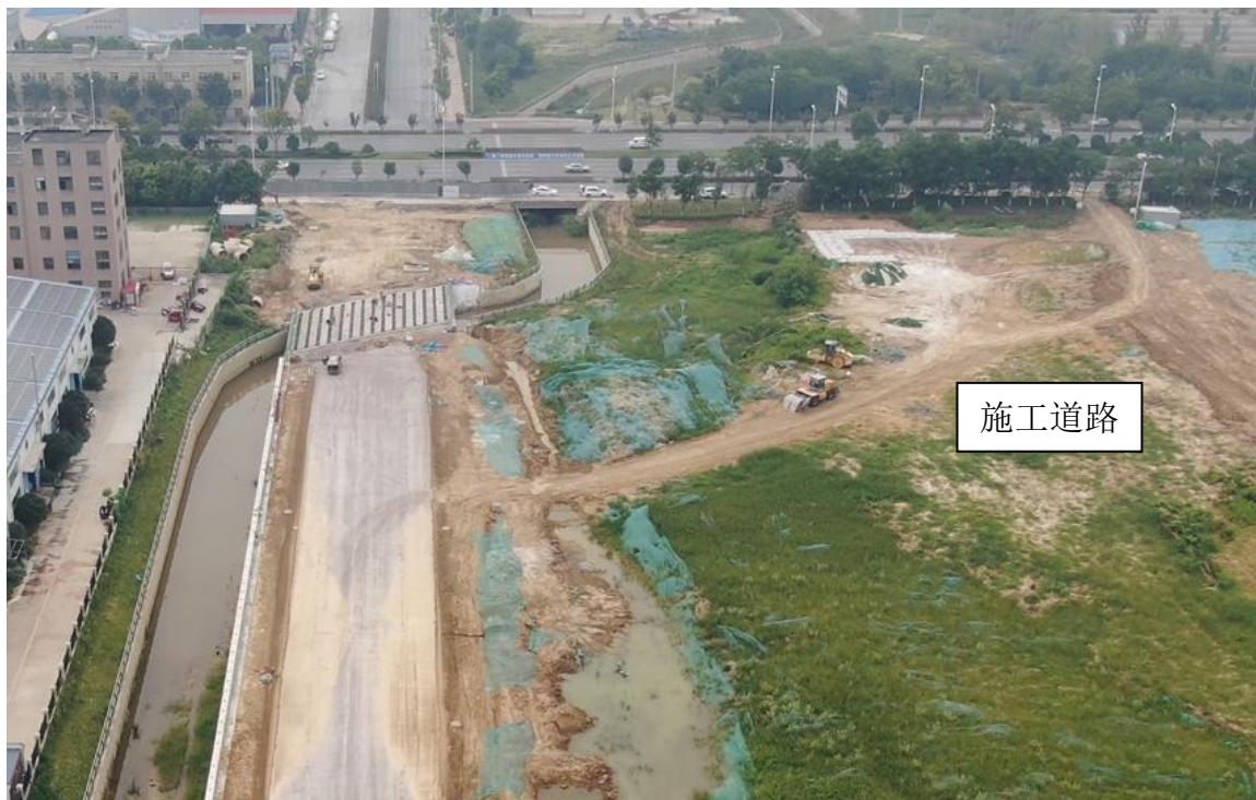
施工道路现状
