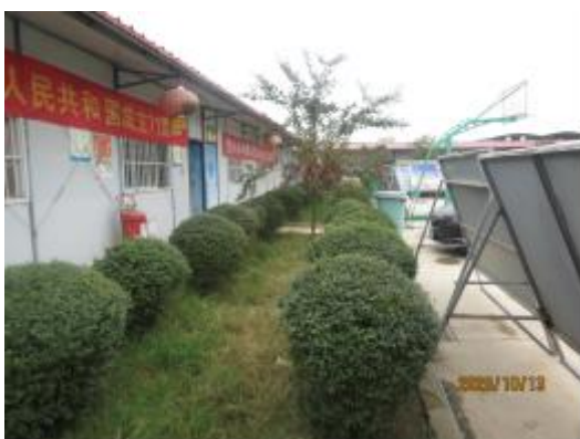
施工场地临时绿化
