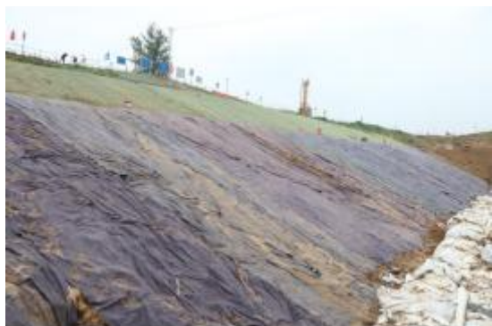
船闸开挖边坡苫盖
