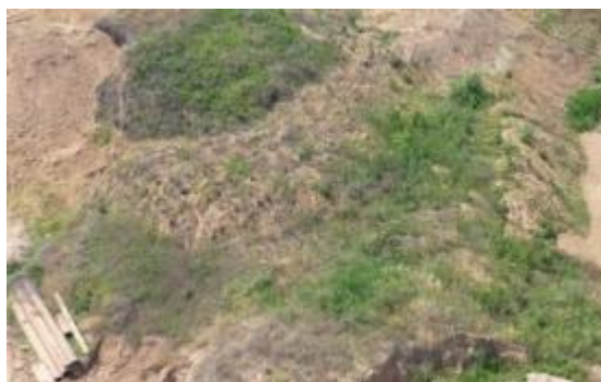
临时堆土场撒播草籽
