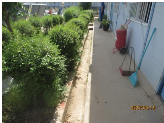
施工场地临时排水沟
