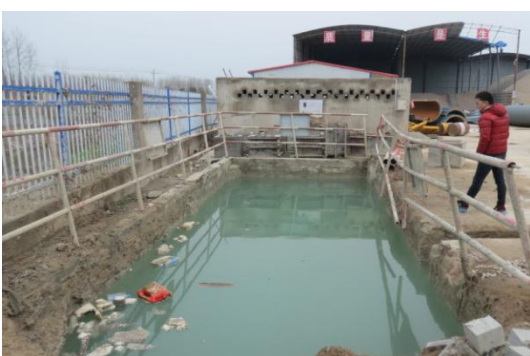
施工场地沉沙池
