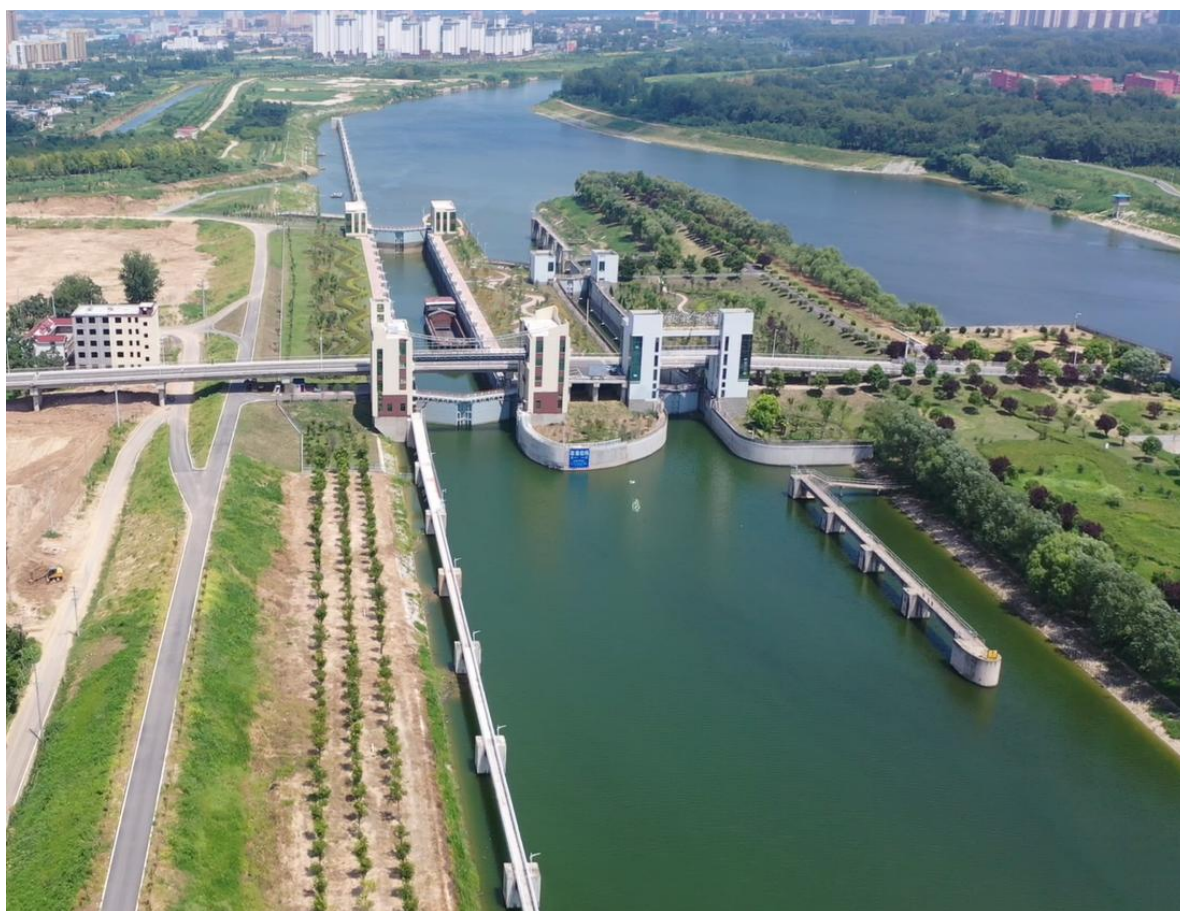
船闸主体工程区现状
