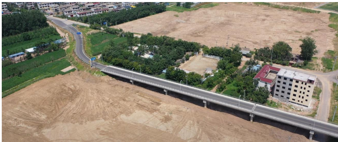
公路桥及接线区现状
