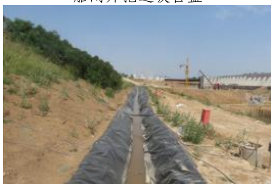
船闸工程临时排水沟
