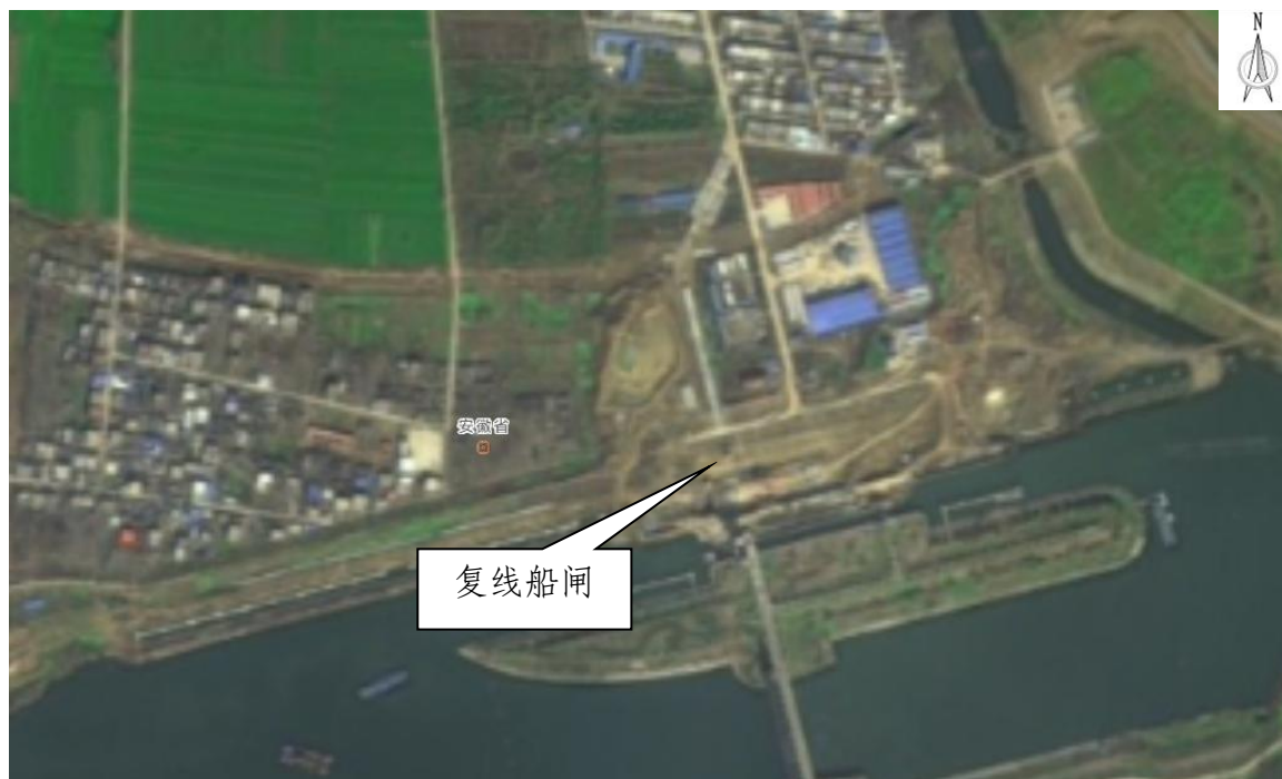
图 1.2. 项目区施工前地形地貌图
