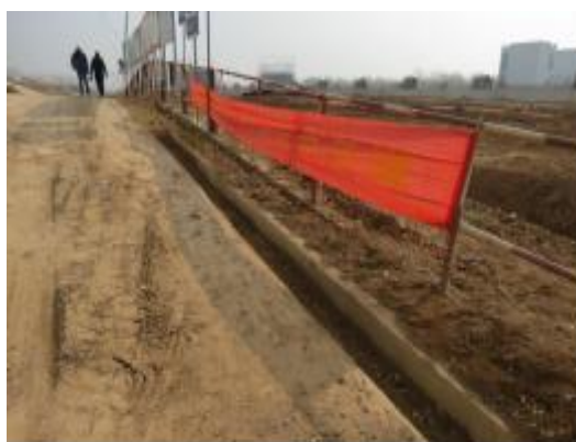
退建堤防临时排水沟
