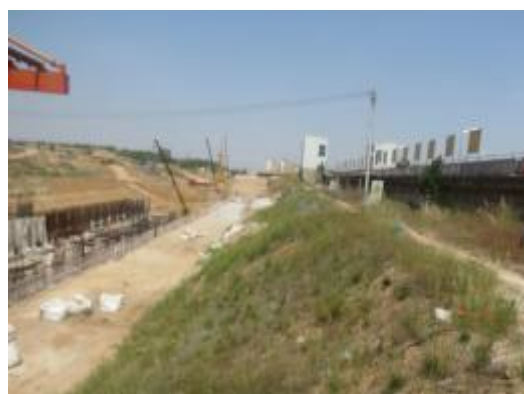
船闸开挖边坡撒播草籽
