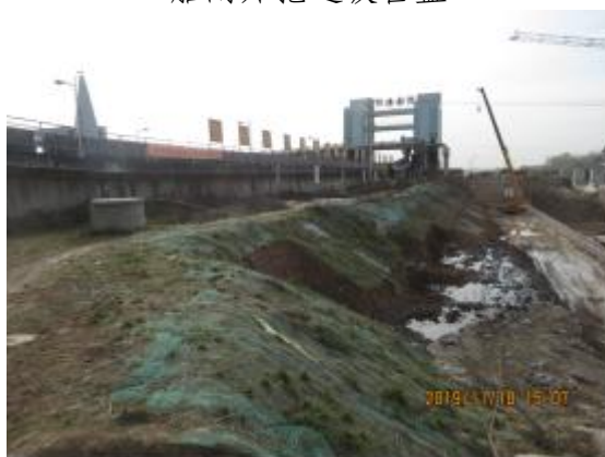
船闸开挖边坡苫盖
