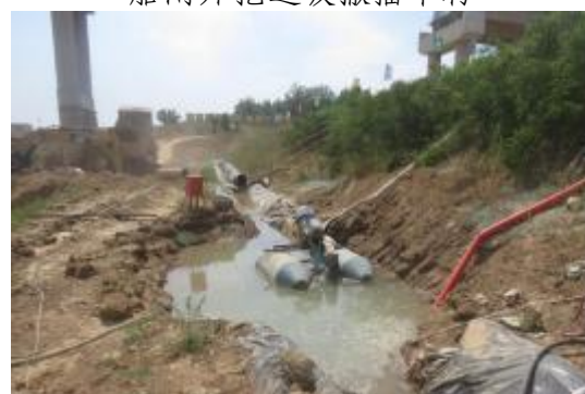
船闸工程沉沙池
