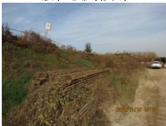
退建堤防临时撒播草籽防护
