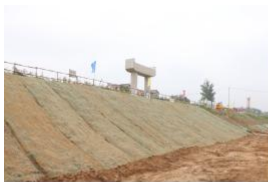
船闸开挖边坡苫盖
