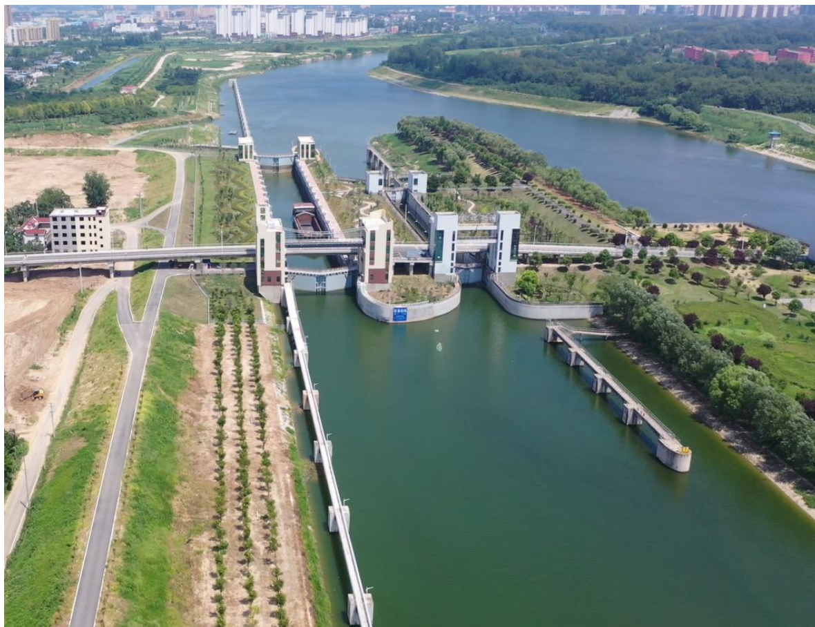
船闸主体工程区现状
