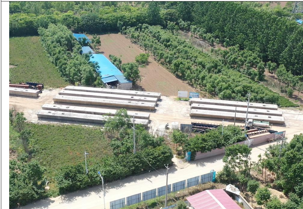
施工中桥梁预制场位于路基工程占地内
