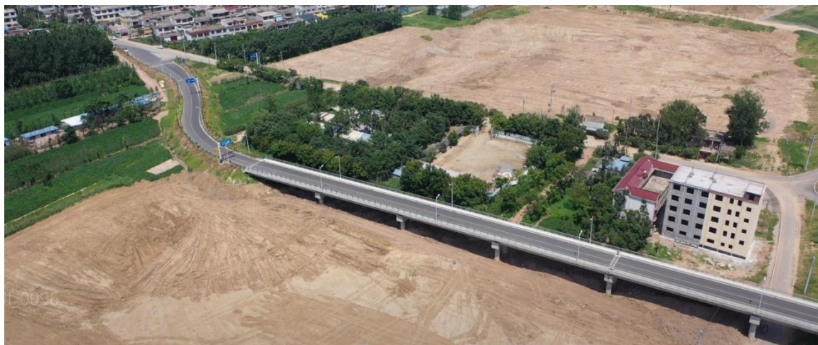
公路桥及接线区现状
