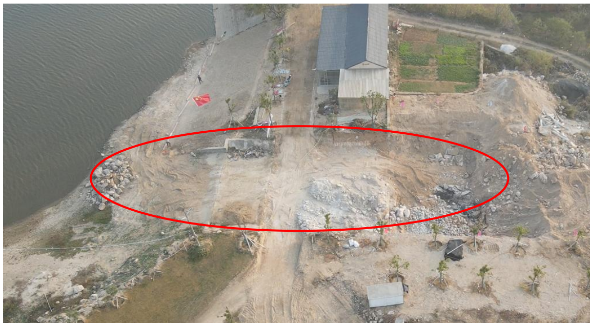
溢洪道现状图
