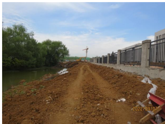
项目区西侧红线外施工扰动现状
