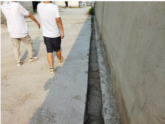
场地围墙边排水沟
