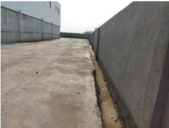
场地围墙边排水沟
