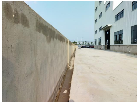
场地围墙边排水沟
