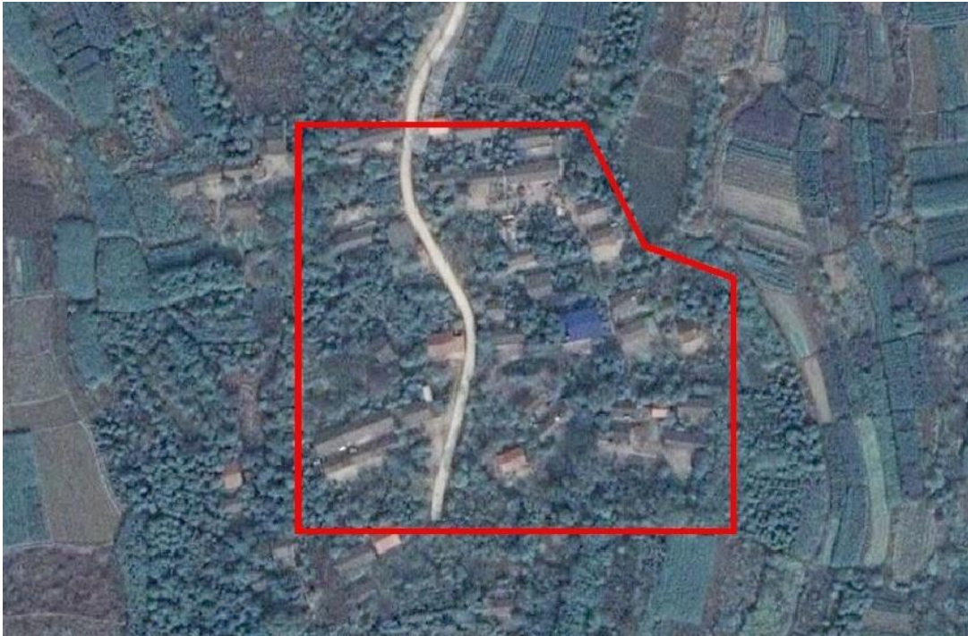
图 1.2 项目区施工前地形地貌图
