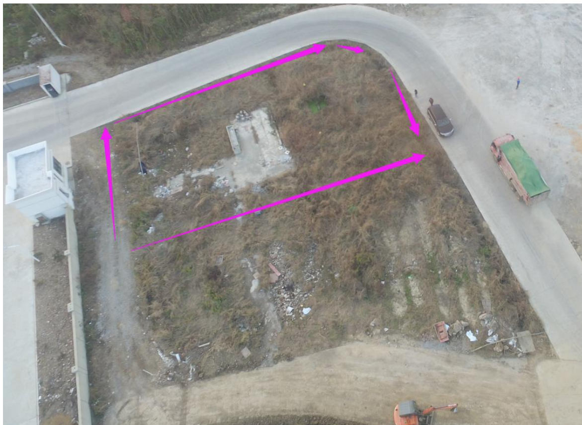
2021年11月（施工临建拆除）
