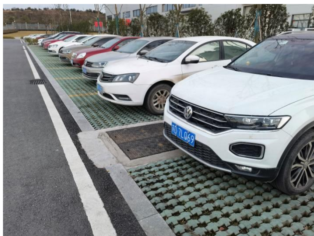
厂区生态停车场
