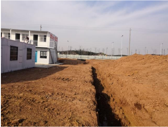
施工场地土质排水沟
