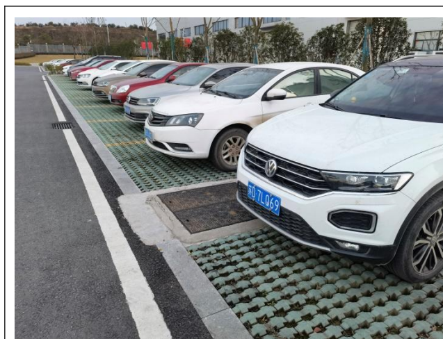
厂区生态停车场
