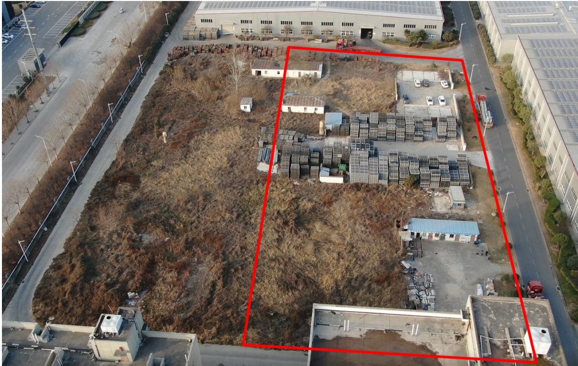
施工场地现状
