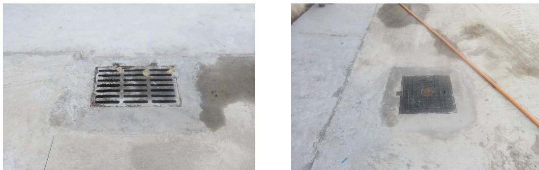
图 1.3 雨水管网建设现状
