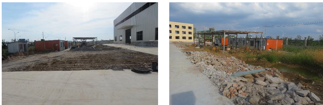
图 1.4 施工场地现状
