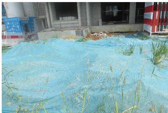
主体工程区密目网苫盖
