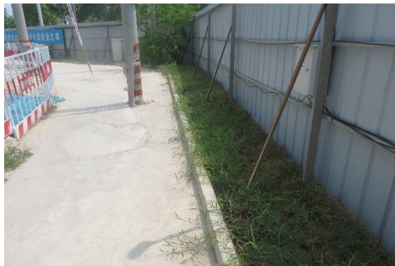
主体工程区撒播草籽
