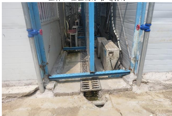
施工生产生活区盖板排水沟
