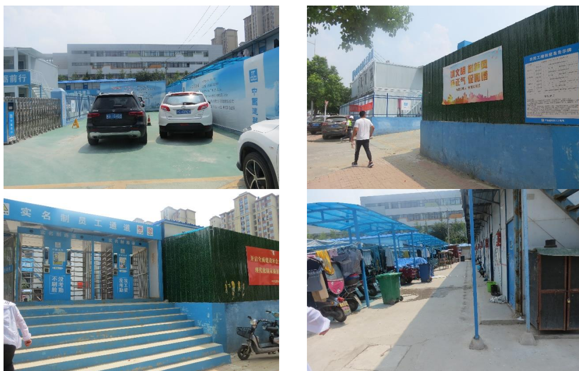
图 2.3 施工生产生活区现状图
