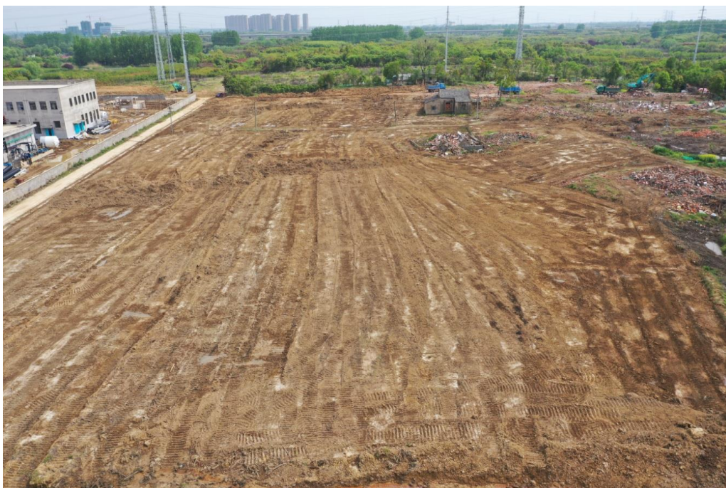
政府初步场平后项目现场情况
