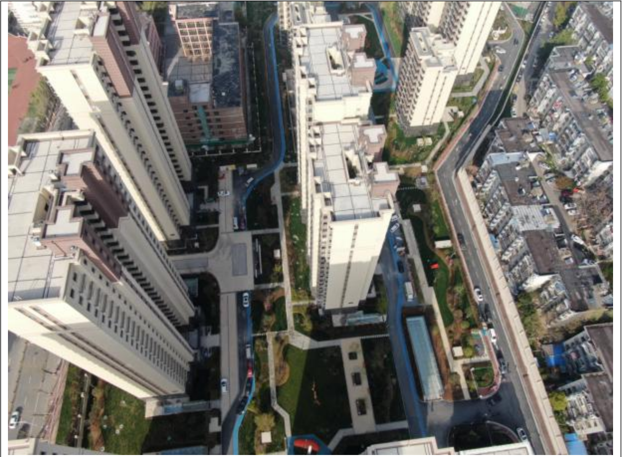
项目区现状（在建工程区）
