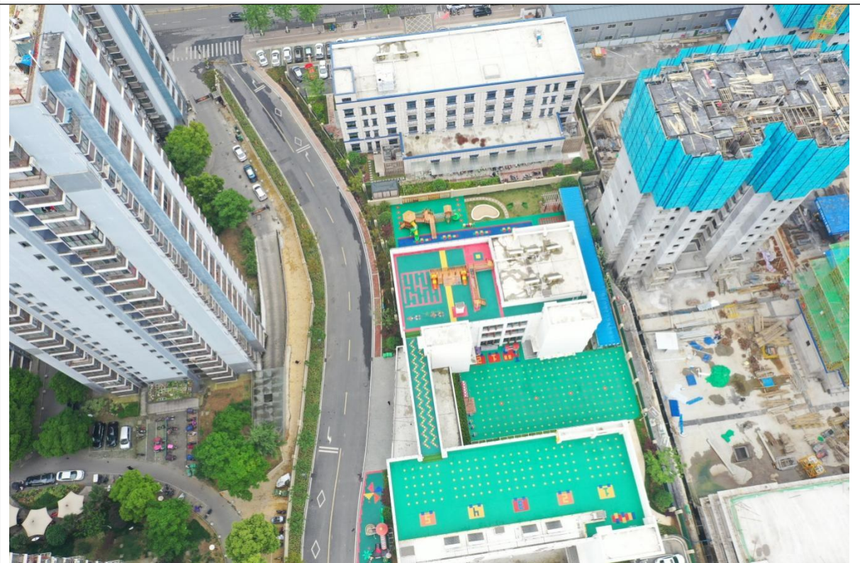
已建区域现状
