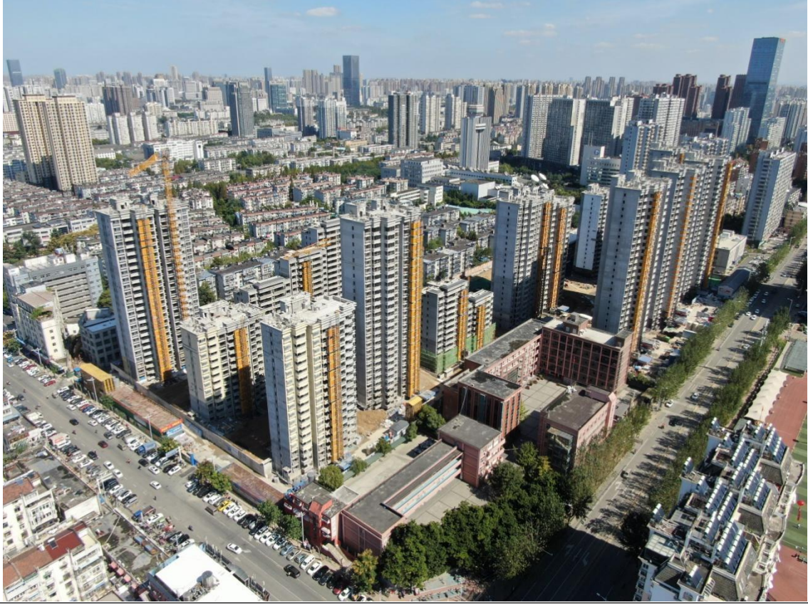
在建工程区现状
