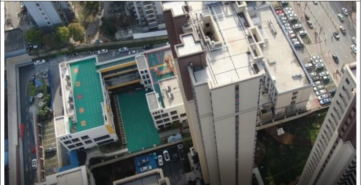
项目区现状（已建工程区）
