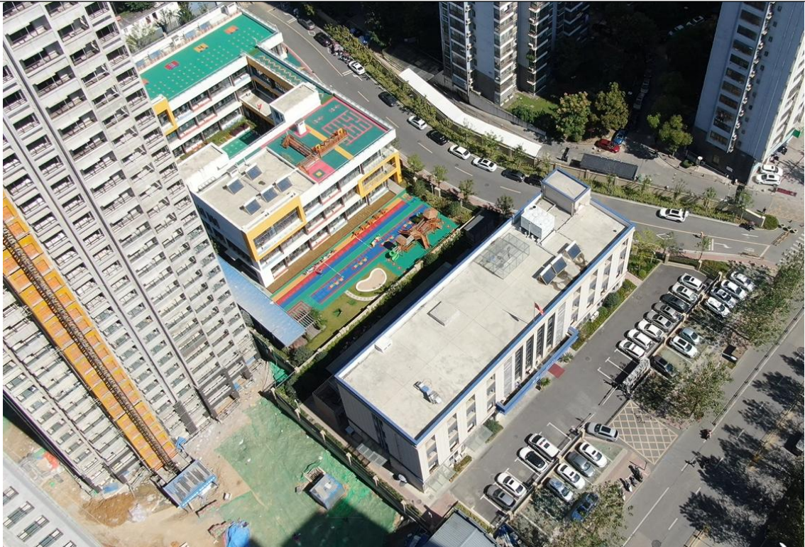
已建区域现状
