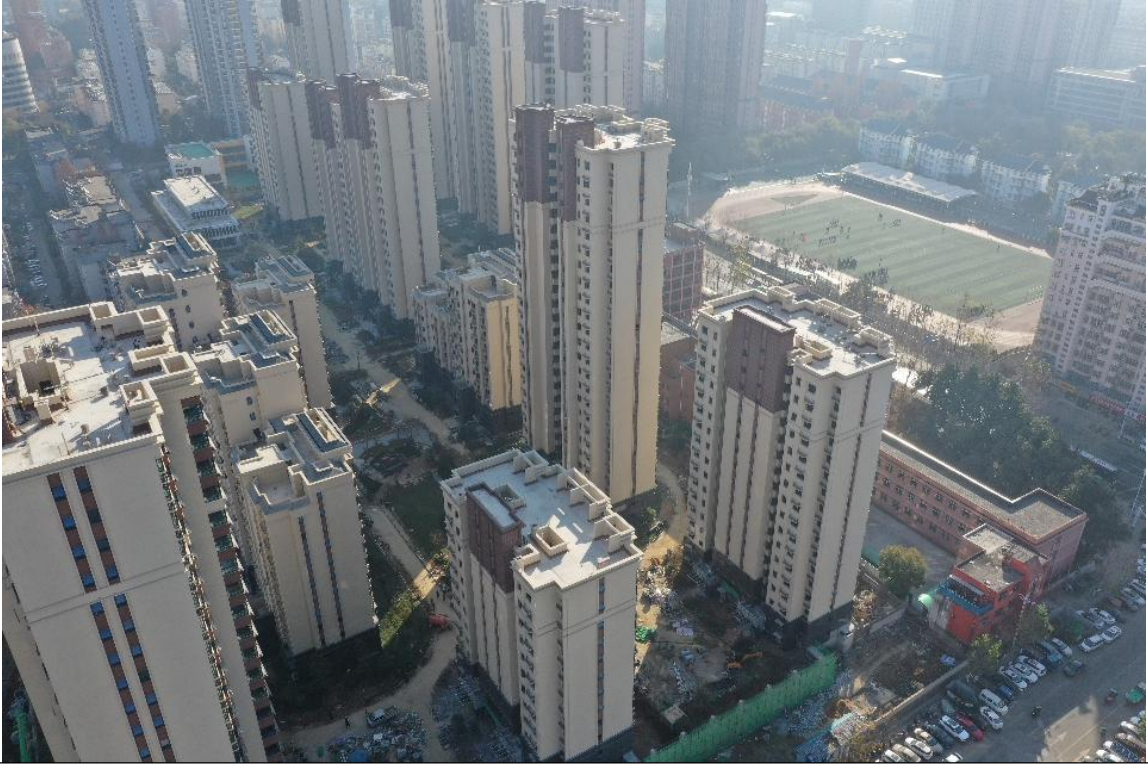
在建区域现状
