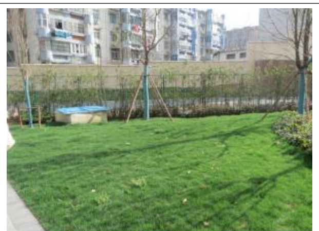
雨水调蓄池（上部已建设绿化）
