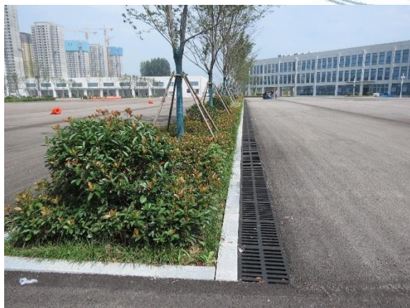
项目区绿化及盖板排水沟
