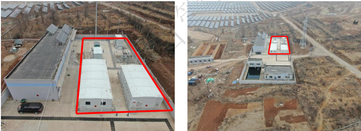
图 1.3 开关站区现状
