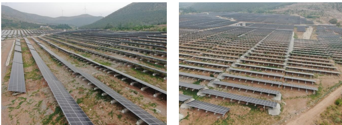
图 1.2 光伏阵列区现状
