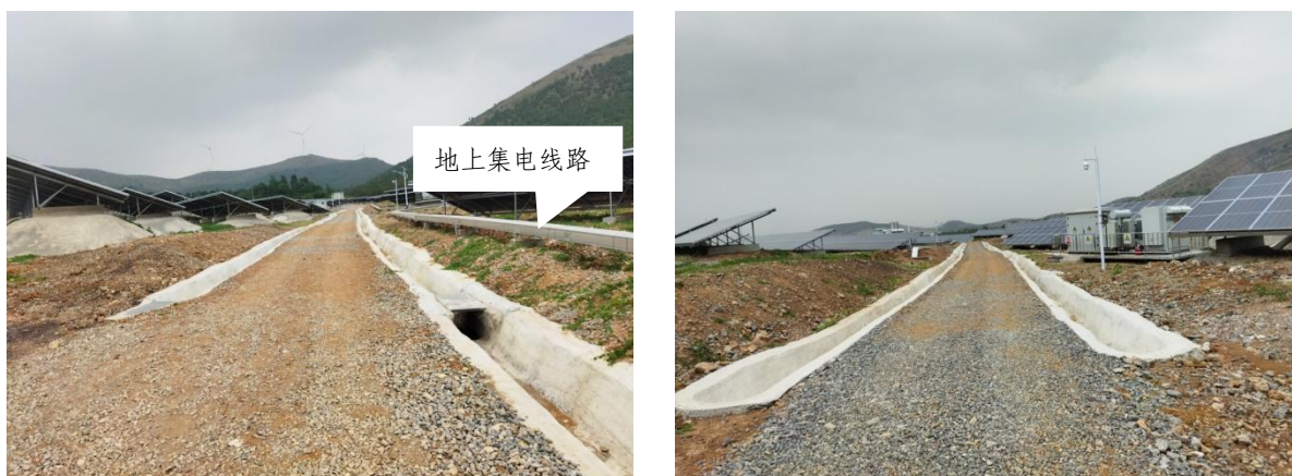
图 1.4 场内道路现状
