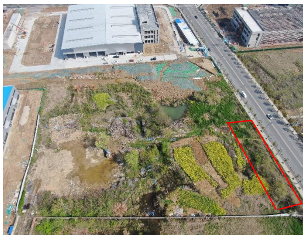
图 1.7 施工场地现状图
