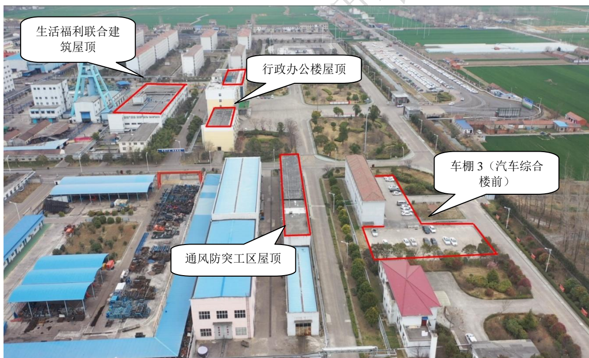
图 1.2 行政办公楼周边光伏组件布设情况
